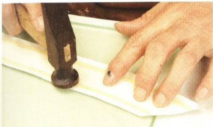
5 用榔頭敲打尼龍膠帶來確實壓著。
